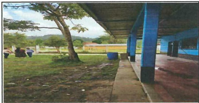
Foto 6: Colocación de canales de metal.
