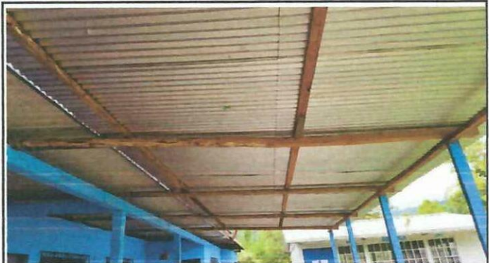
Sustrucion de estructuras metálicas.
