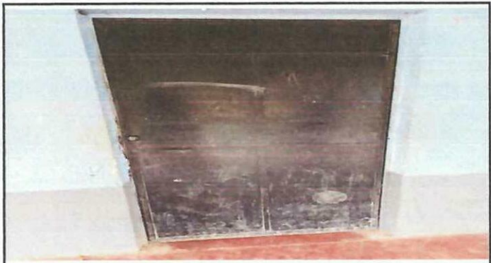
Foto 4: Mantenimiento de puertas.
