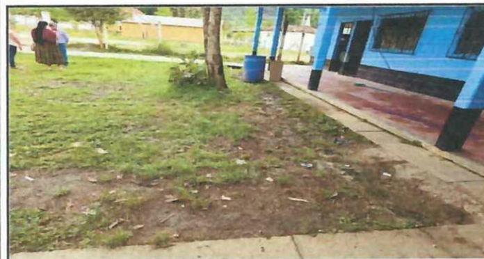
Foto 3: Instalación de piso cerámico.
